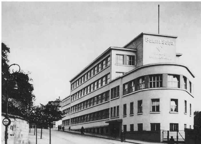
Druckwerke Reichenbach: historisches Foto des Firmenneubaus (1936) in Reichenbach im Vogtland, wo sich noch immer der Firmensitz befindet.
